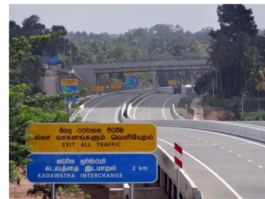
開通した外郭環状道路の一部
