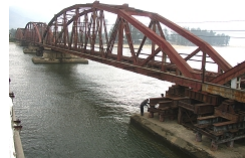
▲橋梁架け替え(東南アジア)
