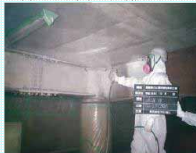
アスベスト除去状況
