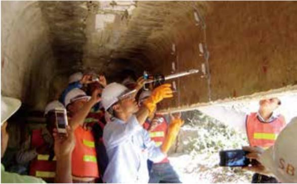
橋梁PC桁における、ひび割れ補修作業の実地研修。
