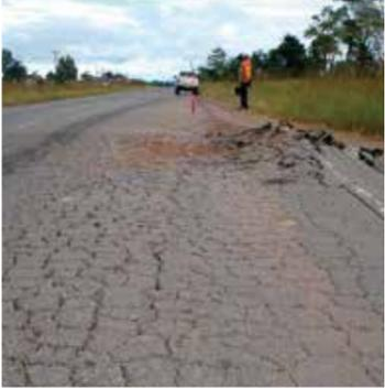
幹線道路の舗装面に発生した亀甲状のひび割れと路肩の変状。
