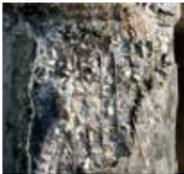
腐食により内部の鉄筋が露出した橋脚。
