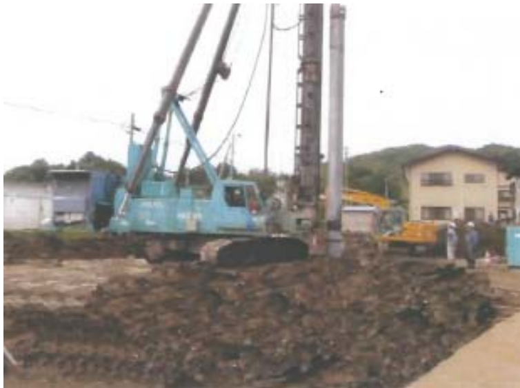
【公営住宅の基礎杭施工風景】
