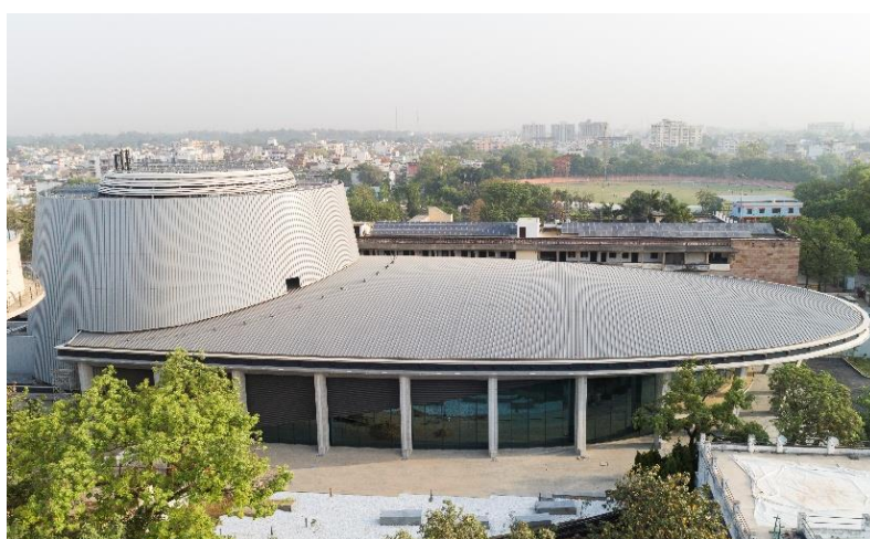
受賞プロジェクト バラナシ国際協力コンベンションセンター建設事業 (インド)
