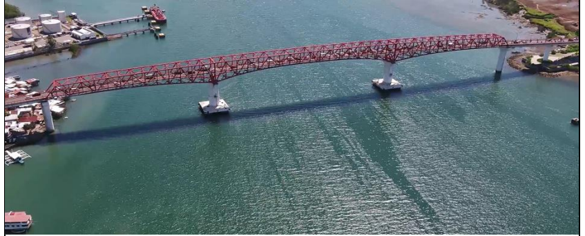
受賞プロジェクト 新マクタン橋建設事業準備調査および詳細設計調査フェーズⅡ (フィリピン)
