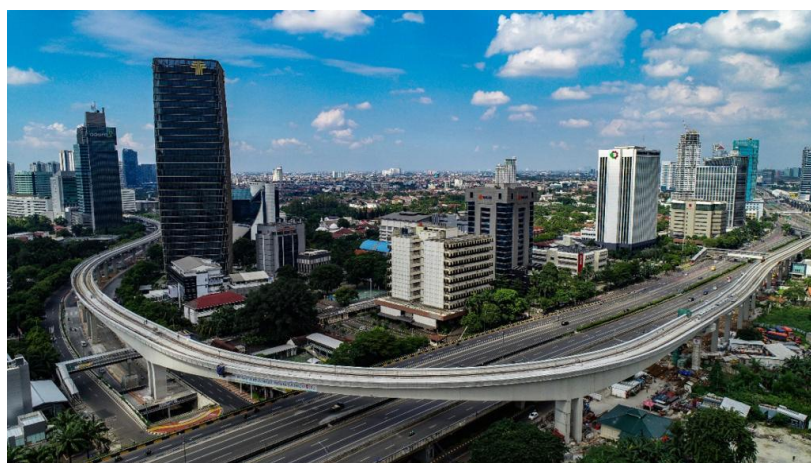
受賞プロジェクト 西ジャワ州ジャカルタ首都圏 LRT 建設施工監理コンサルティングサービス (インドネシア)
