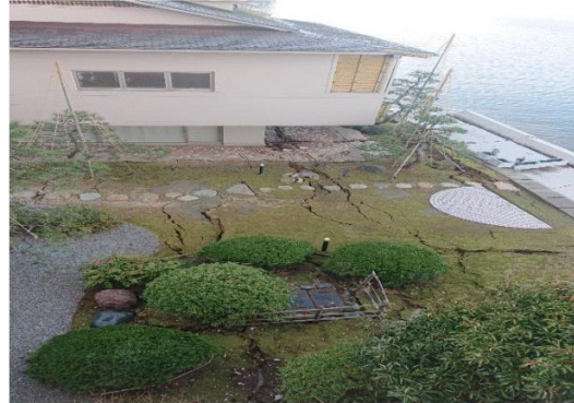
地震による地割れ被害
