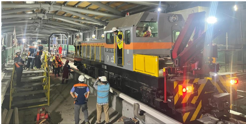
施工中の新駅に対しメンテナンス車両を用いて実施した入線試験の様子
