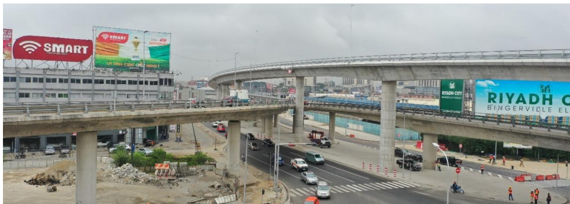
フライオーバー交差点中心部
