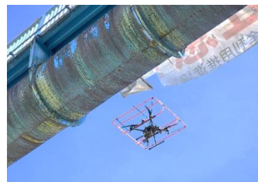
【ガードドローンによる水管橋点検】
