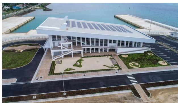
同社が設計施工監理等に携わったトンガ国ヌクアロファ タウファアハウ・トゥポウ4世港フェリーターミナル 正面には日本との友好の印として日本庭園がしつらえられた
