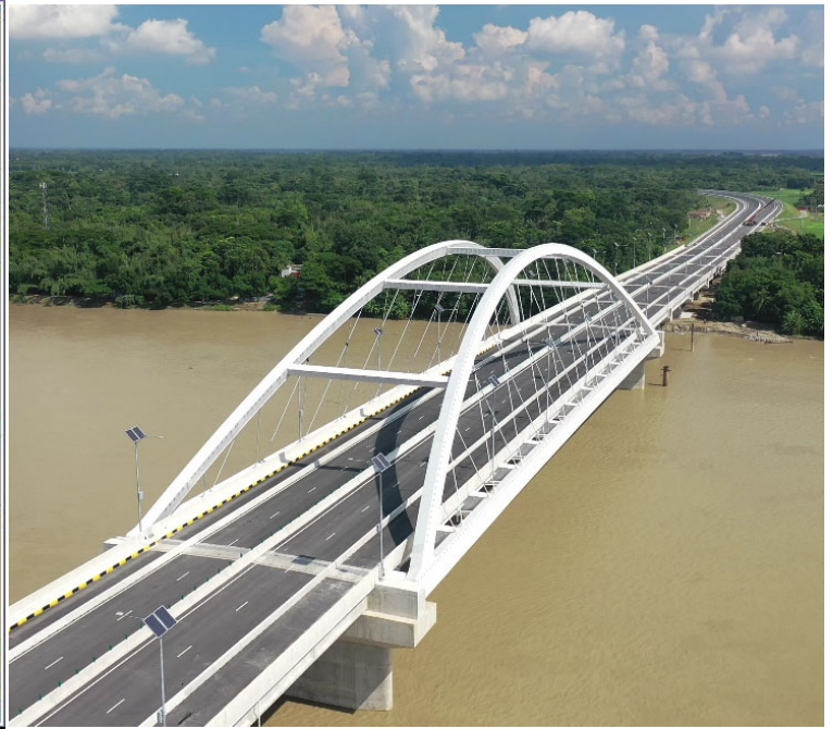
完成したモドゥモティ橋
