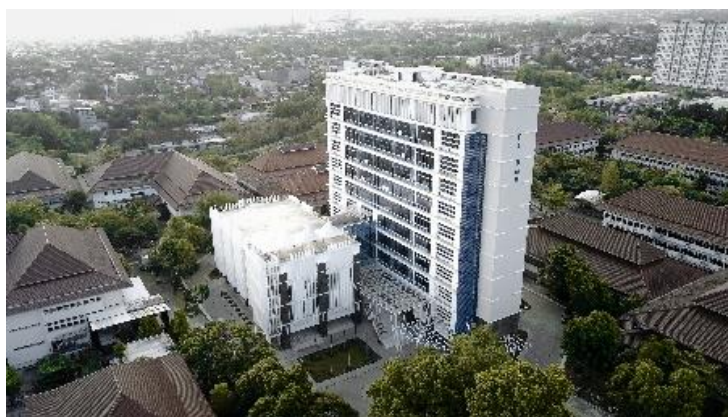
工学部本部棟 インドネシア初のゴムダンパー制震構造を採用
