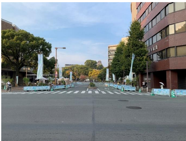
〈道路規制(4車線 ⇒ 2車線)の様子(南側より)〉
