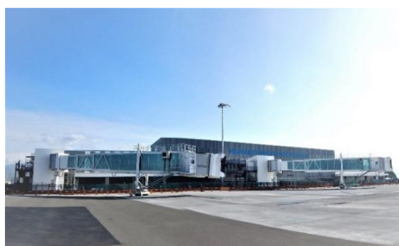
新設された旅客ターミナル全景
