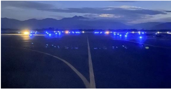
拡張誘導路と新設された航空灯火
