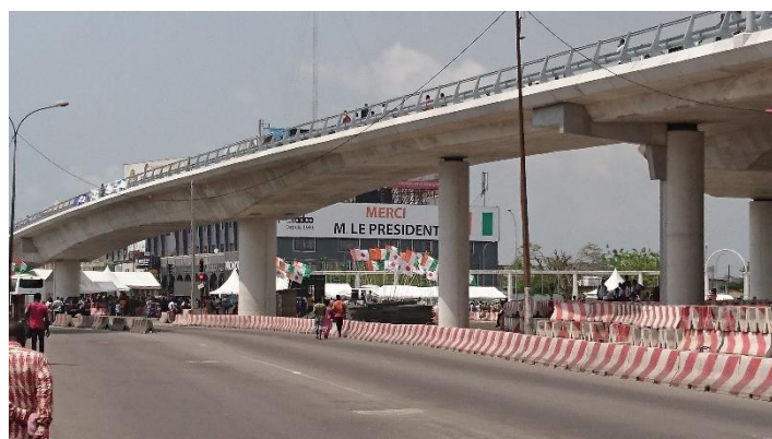
高橋さんが従事した 日本・コートジボワール友好交差点 跨道橋
