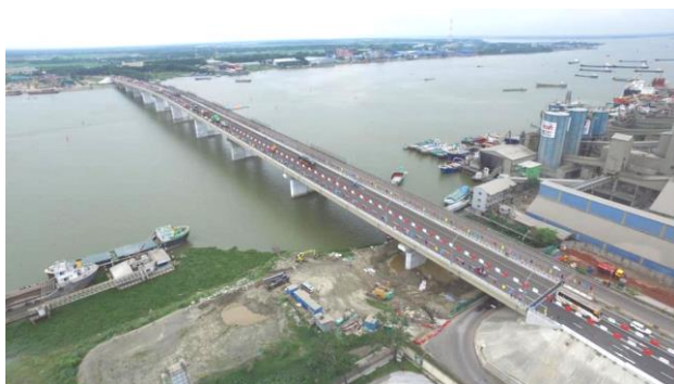
完成したメグナ第2橋梁と既設橋
