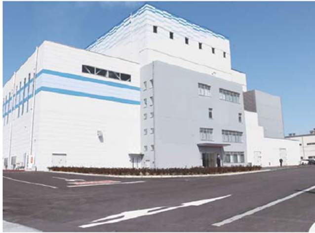
完成した新河北郡市クリーンセンター＝津幡町能瀬
