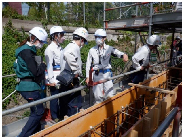
施工見学会の様子
