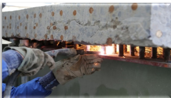
写真-1 : ウォータージェットで除去したコンクリート
