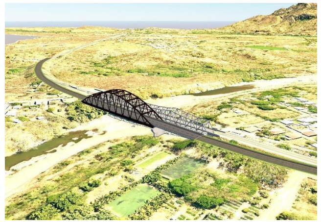
新グアシロペ橋 CG（手前） 耐候性鋼トラスドラムアーチ橋+PC 箱桁橋 橋長 160m
