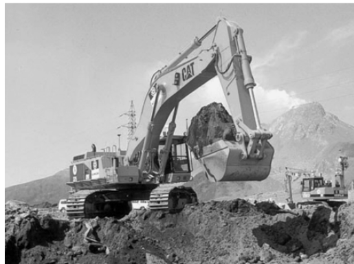
図2 無人化施工による除石工事 [土木学会誌，Vol. 89，No.7]
