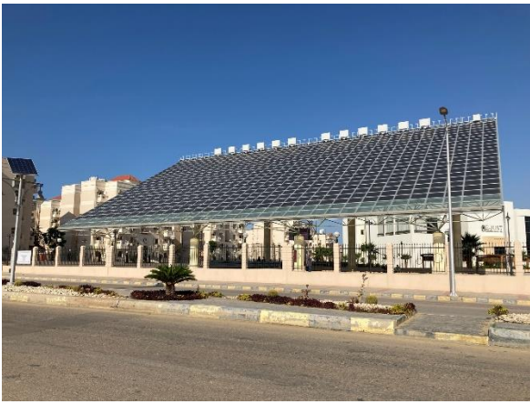
ATRIUM に設置した太陽光パネル 様々なイベント、アクティビティが行えるよう自然光が入るシーズルパネルを導入した。
