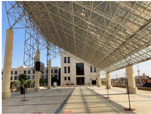
ATRIUM に設置した太陽光パネル 様々なイベント、アクティビティが行えるよう自然光が入るシーズルパネルを導入した。
