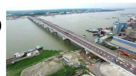
完成したメグナ第2橋梁
