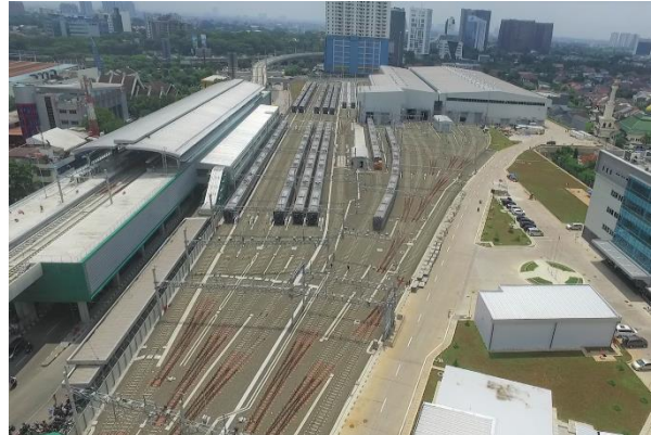
日本の車両基地をモデルに設計・施工したレバックブルス車両基地 (東急建設)
