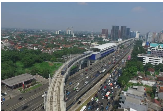
ファトマワテイ駅と高速道路を跨ぐ急曲線長大橋 (東急建設)
