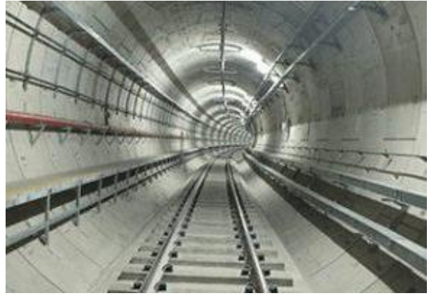
漏水のない高品質なシールドトンネル(清水建設)
