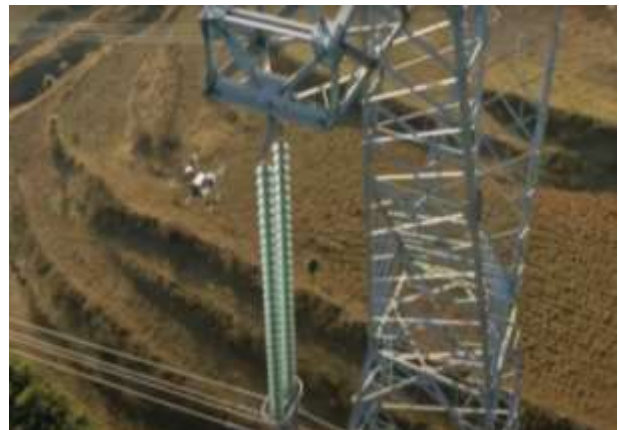
② 望遠ズームと標準カメラを同時搭載したドローン活用による効果的点検
