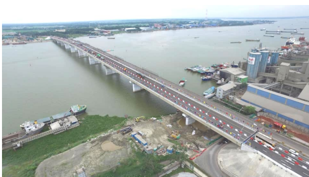
完成したメグナ第2橋梁と既設橋
