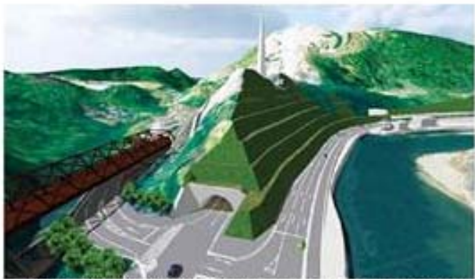
一般国道176号名塩道路城山トンネルでは設計から施工、維持管理までワンモデルでつなぐ
