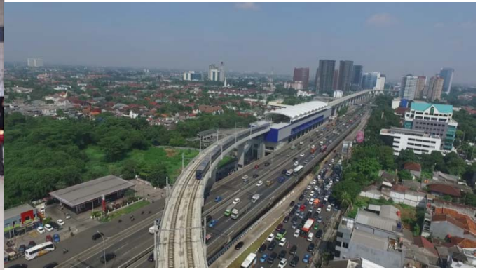
ファトマワテイ高架駅と長大橋 (写真：東急建設様 提供)
