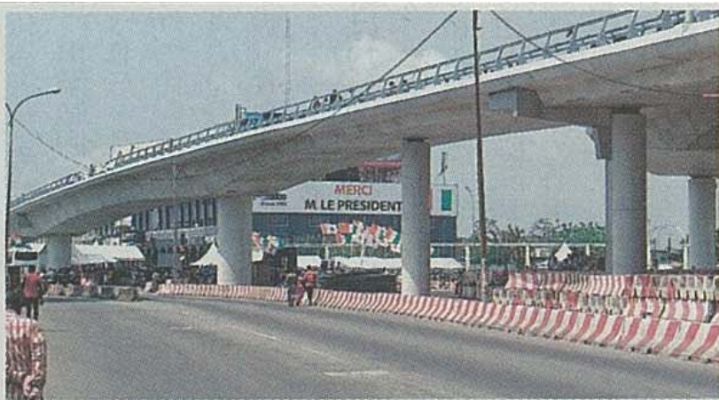
開通した跨道橋
