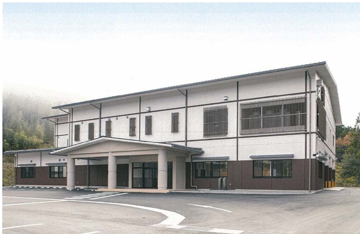
汚泥処理センター「アクアクリーン中津川」
