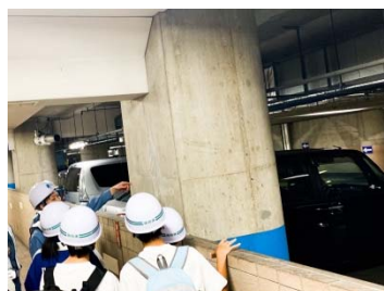
ひび割れ幅測定
