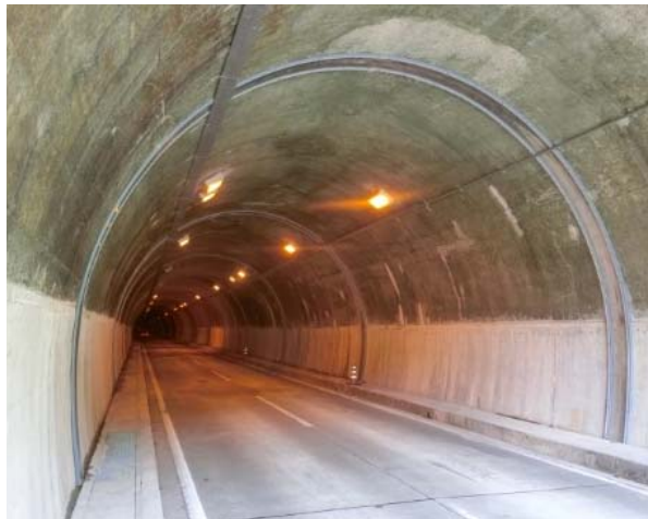
補修後の糠越隧道
