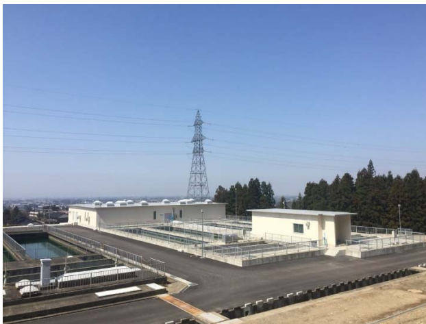
【松島浄水場全景】
