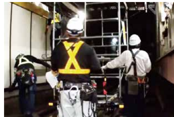
駅舎点検の現場写真 (「賢者の選択」より引用)
