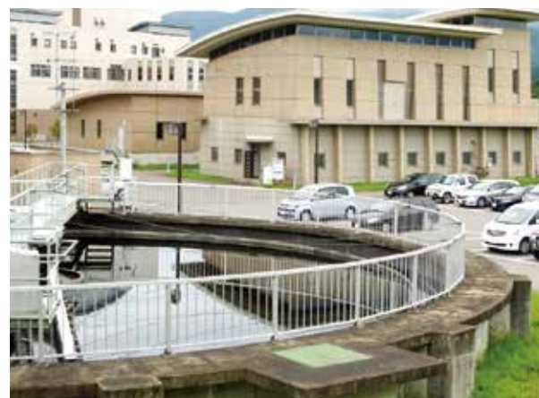
大野市下水処理センター [福井県大野市]
