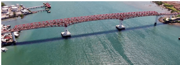
第一セブ・マクタン橋は全長約860m。1976年に完成し、現在もメトロセブ地域の経済発展を支える。
