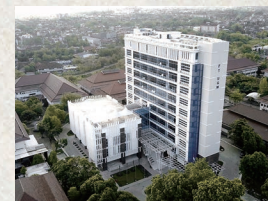
インドネシアで初となるゴムダンパー制震構造を採用した、工学部本部棟。
