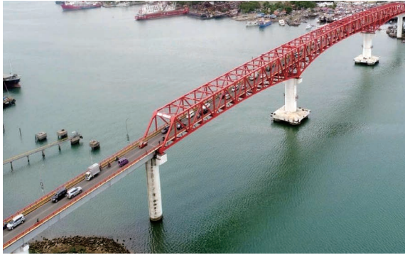
第一セブ・マクタン橋の全景。海峡部の3径間連続トラス橋と、両側取付け部の鋼桁橋からなる、全長860mの鋼道路橋。
