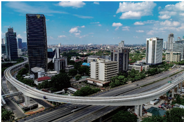
鉄道橋では世界最長の径間(148m)となるクニンガン橋
